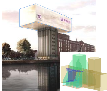
Museum Koppersmühle, Duisburg, Detailsstatik FE-Analyse der Hauptknoten
